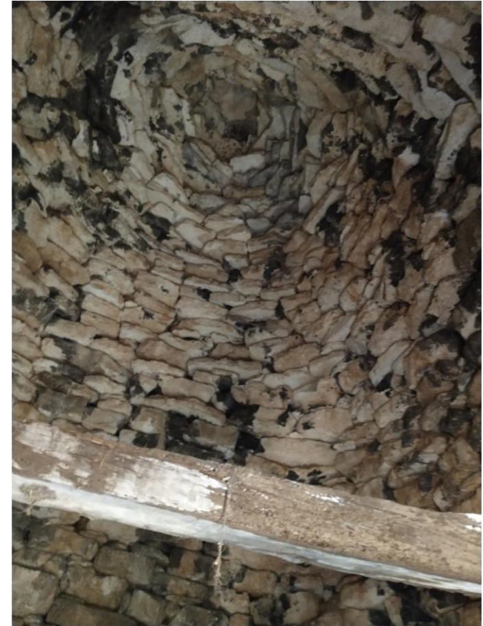
Vue de l'intérieur sa voute
