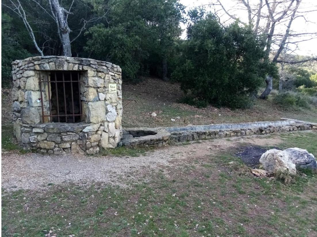
**Le Puits de l'Aroumi** qui est en pierre, est situé à 500m au nord du col du Tubé, au sud d'une petite clairière. Il est fermé par une grille (cadenassé). Il y a un bac en pierre accolé pour que les moutons puissent y boire. Un levier à l'arrière permet d'actionner une pompe pour faire couler l'eau du puits vers le bac... Il est utilisé principalement par les bergers . La clairière avec son puits et son immense chêne (l'arbre de vie) est le lieu idéal pour un bon pique-nique..
